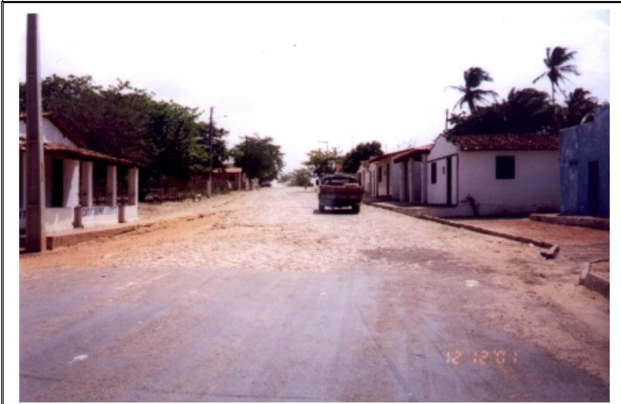
**FOTO 09** – VISTA DE ENTRADA DO DISTRITO DE CÔRREGO FUNDO DEMONSTRANDO O FINAL DO PAVIMENTO ASFÁLTICO E O INÍCIO DO PAVIMENTO POLIÉDRICO QUE REVESTI UNICAMENTE A VIA PRINCIPAL DO DISTRITO. OBSERVA-SE AINDA O PADRÃO DAS MORADIAS E DOS ESTABELECIMENTOS COMERCIAIS DO LOCAL.
